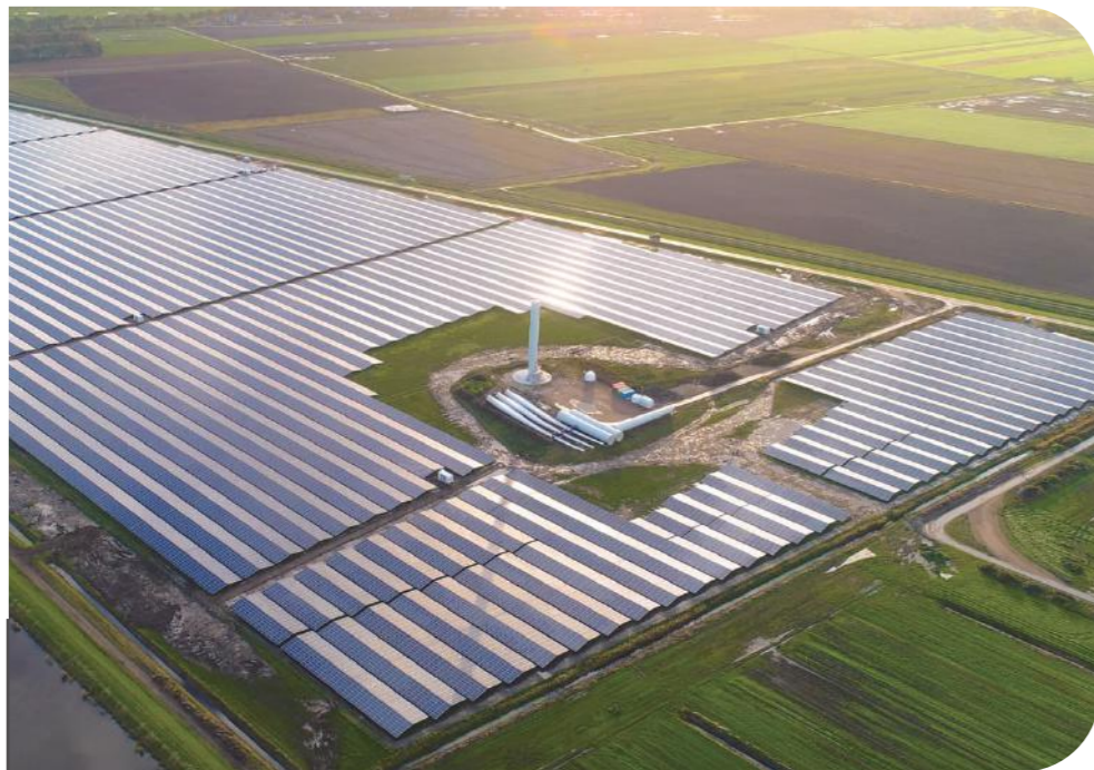
Duurkenakker Solar Power Plant
